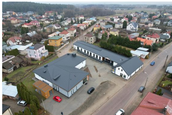
Adaptacja budynku do pełnienia funkcji Biblioteki Publicznej w Dąbrowie Białostockiej
